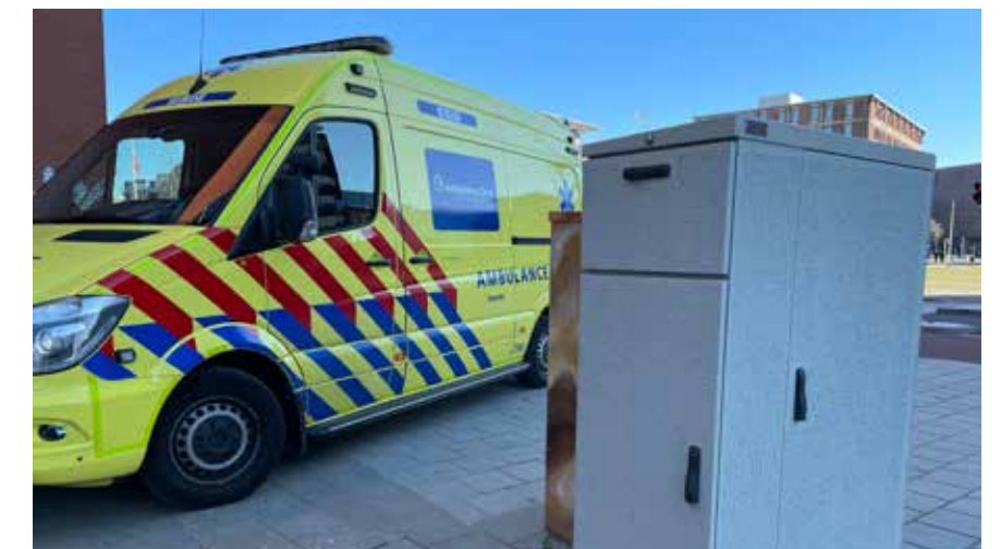
▼ De iVRI, deze kast staat naast intelligente verkeerslichten.
